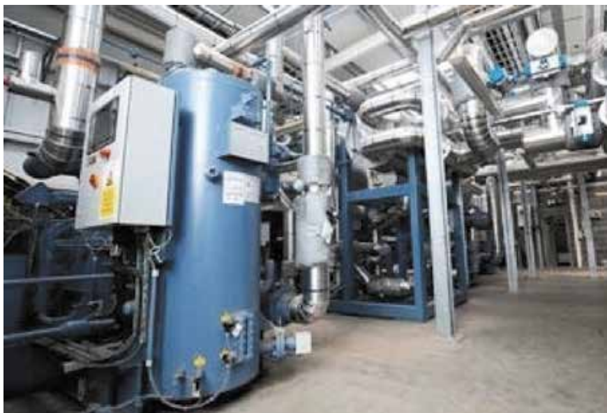
Obr. 2: Důležitým faktorem je použití čpavku jako chladiva
