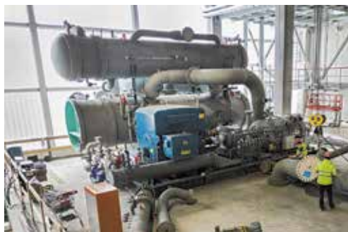
Obr. 1: Montáž velkokapacitního TČ ve vídeňské centrální čističce. Do roku 2027 se počítá s výkonem 110 MW, který pokryje potřebu 112 000 domácností.
