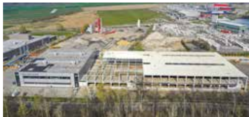
Polský závod Thermofin, vlevo je stávající výrobní hala.
