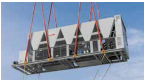
Průběh instalace jednotek ve výšce 142 m
