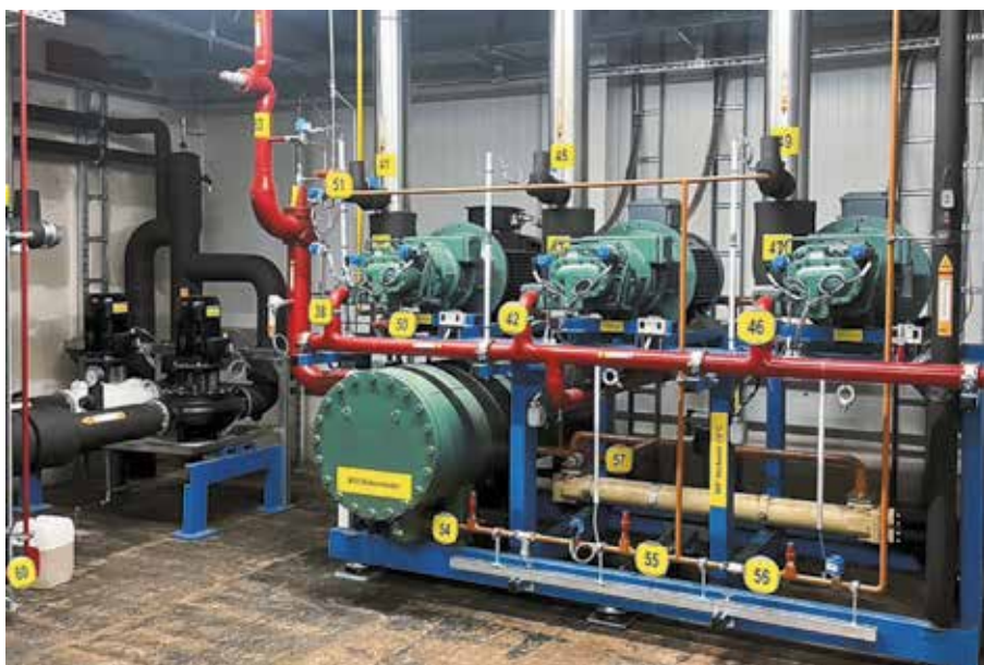
Sdružená jednotka se šroubovými kompresory Bitzer
