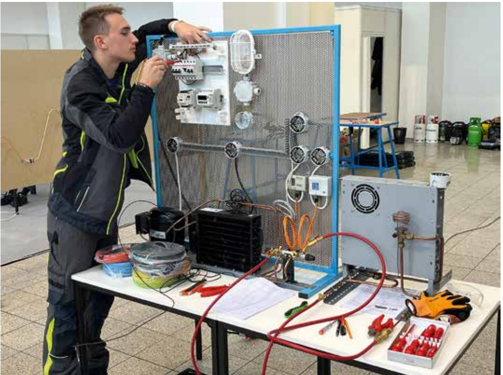
Obr. 6: montáž elektroinstalace a nastavení tlakových ochran a řídicí jednotky
